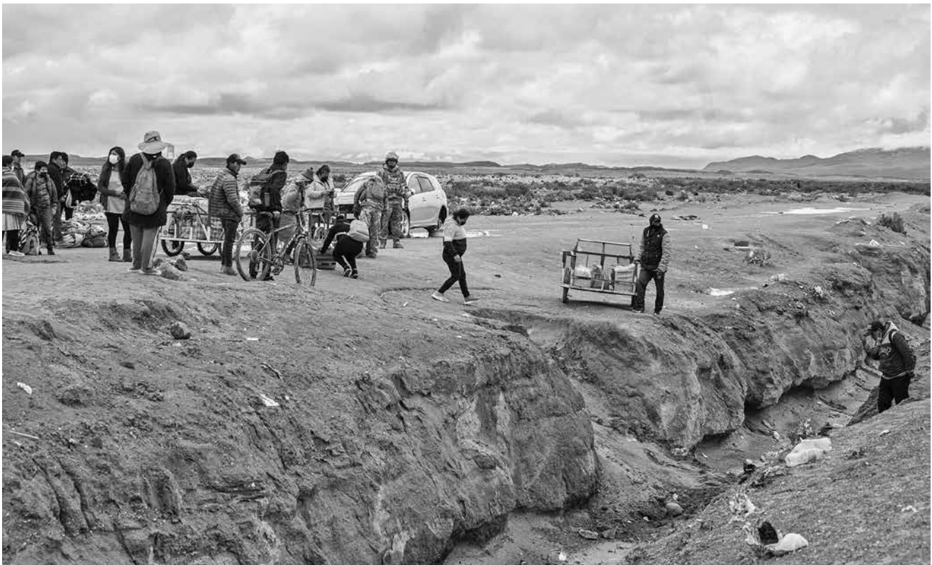
Zanja en el límite fronterizo entre Bolivia y Chile. 2021. Fotografía del autor.
